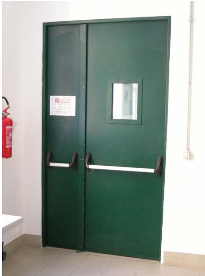
Le uscite d'emergenza sono dotate di maniglione antipanico
