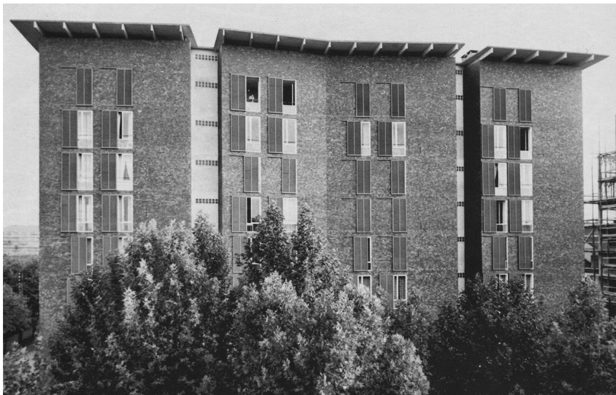
Fig. 11 – La facciata nord, sull'attuale Corso Teresio Borsalino, in una fotografia d'epoca. The north facade, overlooking the present Teresio Borsalino Avenue, in a vintage photograph.
