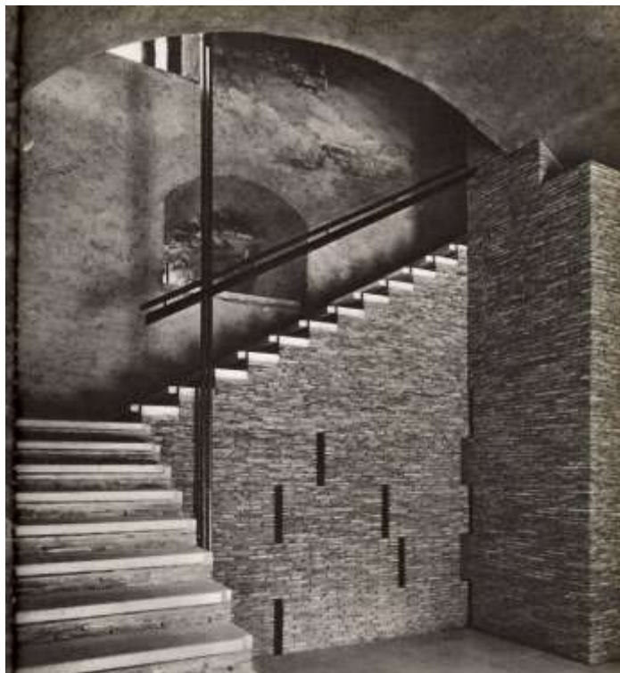
Carlo Scarpa, Museo di Castelvecchio, Verona,, 1956-64 (e segg.). A sinistra: il passaggio dalla Torre del Mastio, attraverso la passerella, al primo piano della "Reggia" scaligera, dove è la pinacoteca. A destra: la scala nuova nella Torre del Mastio costruita con le tavole dei pavimenti.
