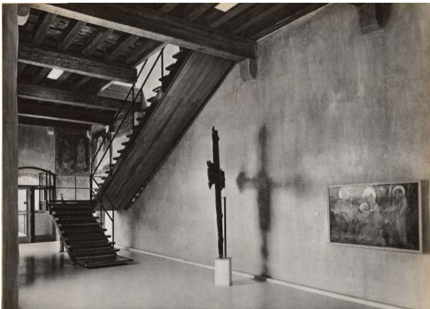
Carlo Scarpa, Museo di Castelvecchio, Verona, 1956-64 (e segg.): la scala in legno e ferro che porta dal primo al secondo piano della "Reggia" (si trova nello stesso luogo dove era costruita quella antica).
