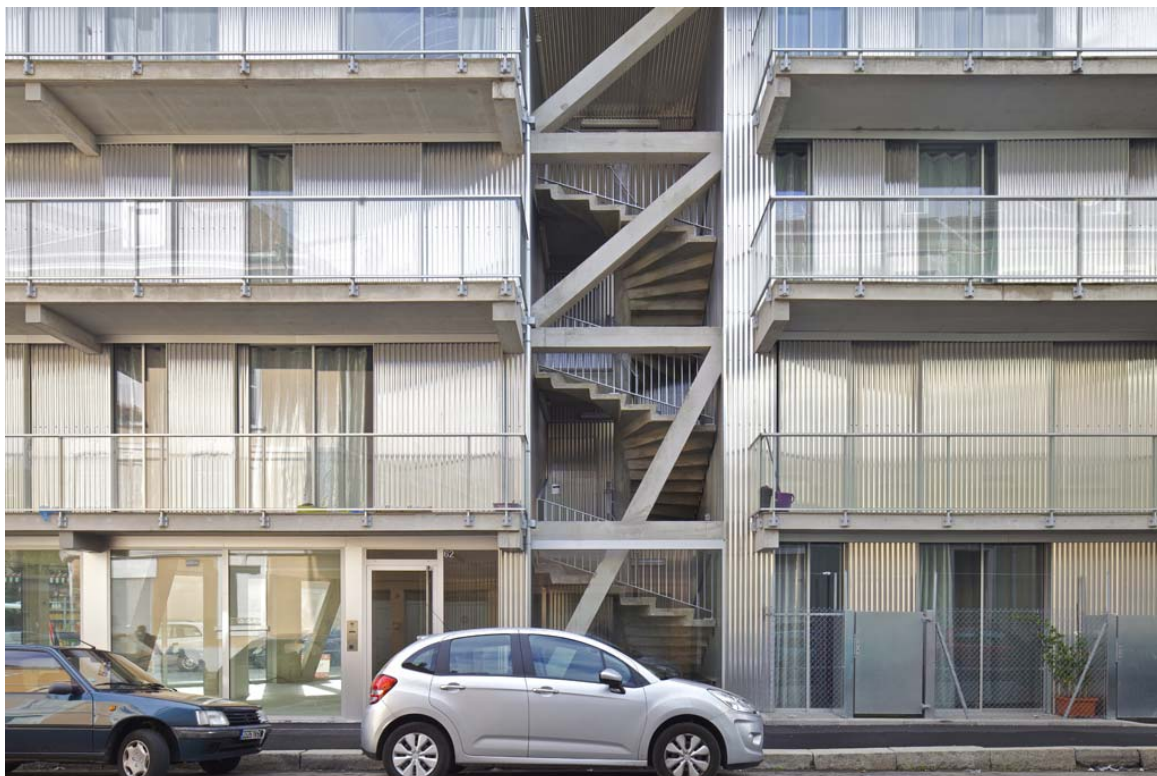
Fig. 13 - Vista esterna di uno dei gruppi scala. External view of a stairway.
