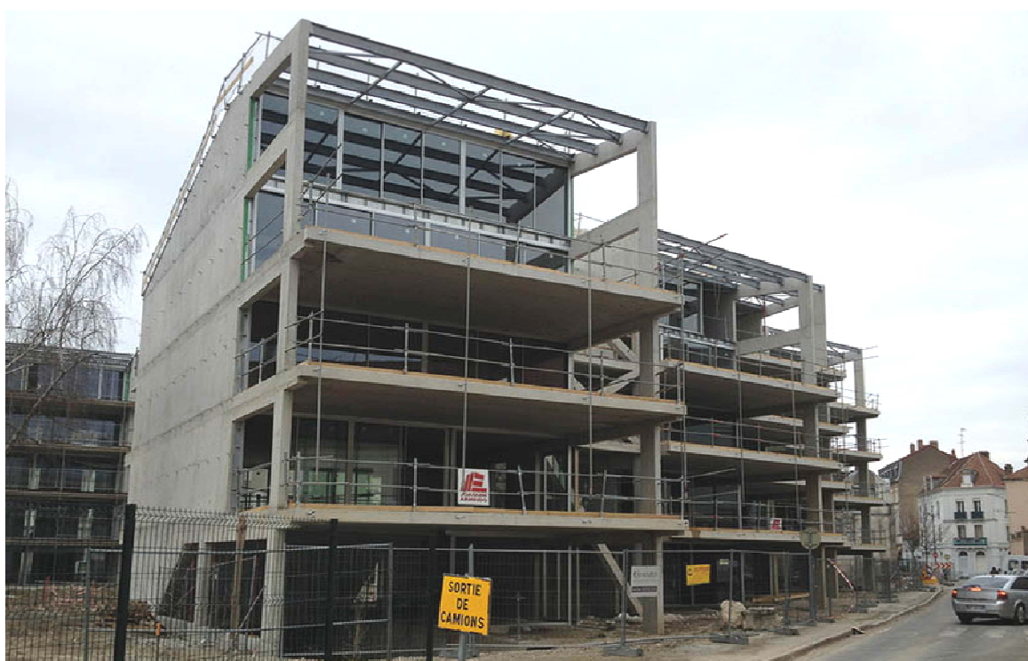
Fig. 14 - L'edificio in costruzione. The building during the construction.
