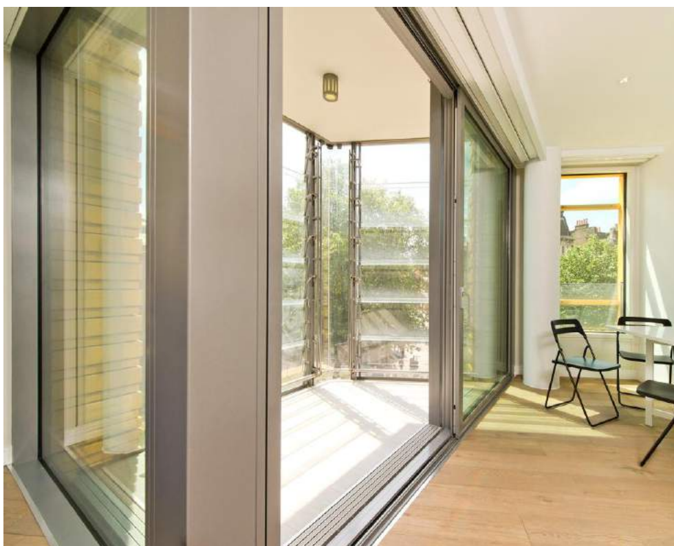
Fig. 20 – Vista delle serre d'angolo dall'interno degli appartamenti
